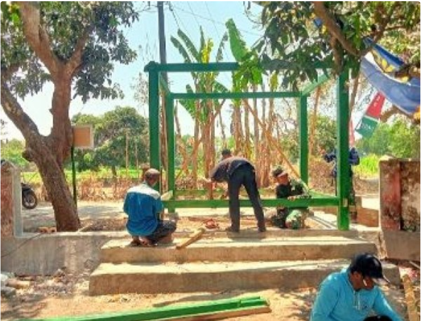
Pengerjaan Poskamling oleh Satgas TMMD Ke-118 Kodim 0829/Bangkalan di Desa Patengteng Kecamatan Modung
