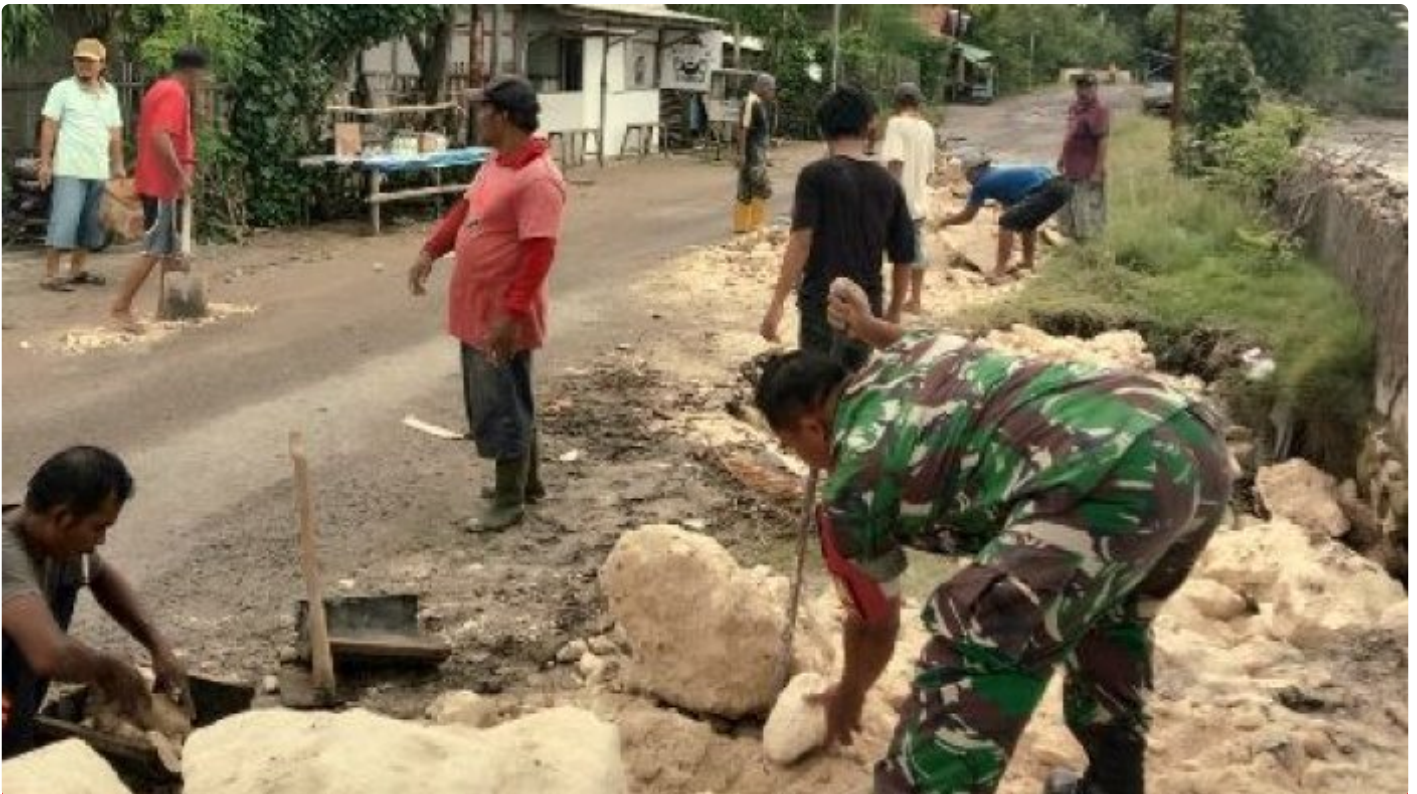
Babinsa Koramil 0829-12/Modung bersama-sama warga memperbaiki jalan yang rusak
